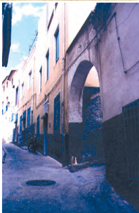
Any 1989. Vista del carrer Arc del Castell
