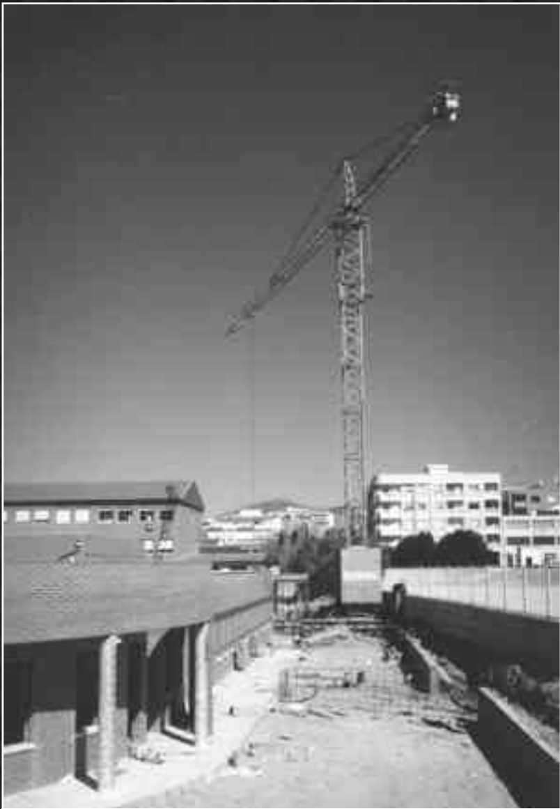
Trabajos de ampliación del colegio Reina Sofía.
