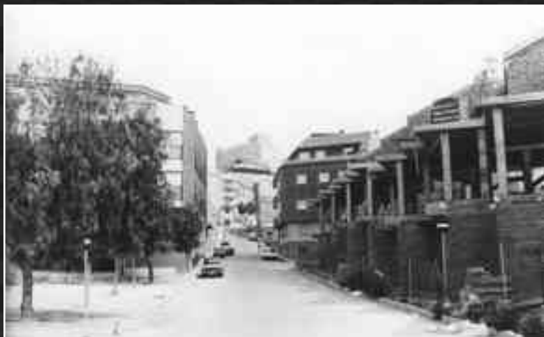
Construcción de viviendas unifamiliares en las inmediaciones de la avenida de Hispanoamérica.
