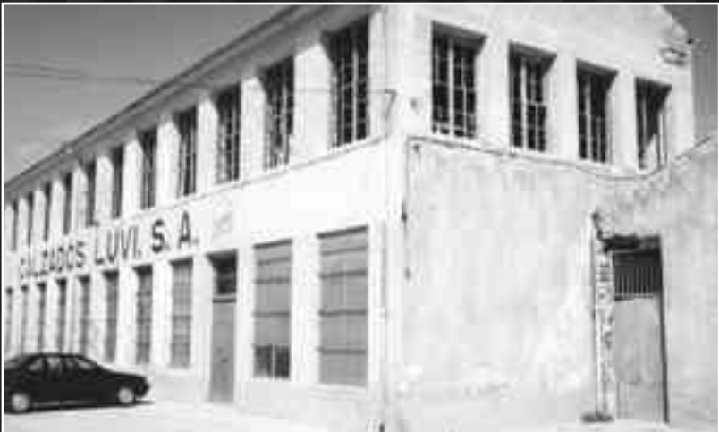
Nave industrial de Calzados Luvi, ya en desuso.
