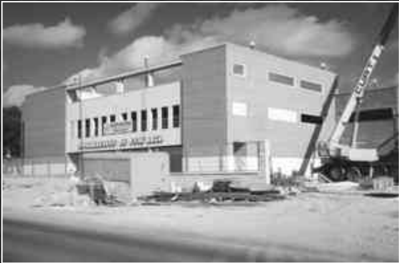
Trabajos de construcción del primer supermercado de Mercadona en Petrer en la avenida del Mediterráneo.
