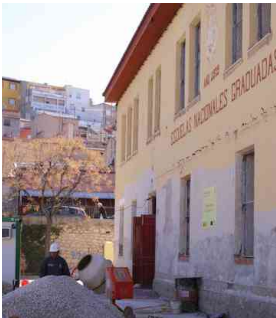
Uno de los empleados de albañilería junto a una hormigonera
