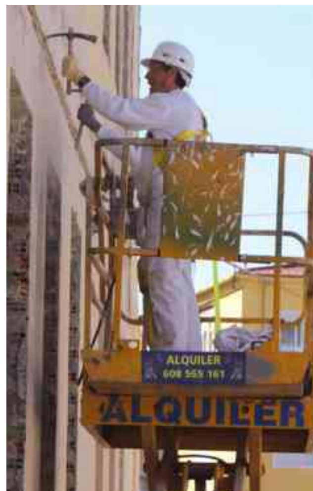
Pintores picando una pared lateral
