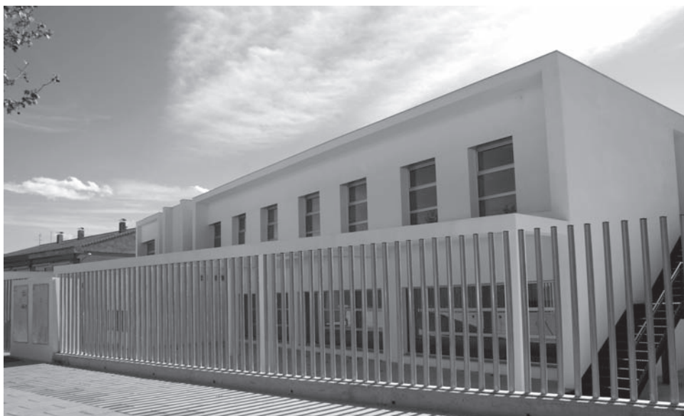
Edificio sin estrenas donde estaba prevista ubicar la Escuela Universitaria de Relaciones Laborales
