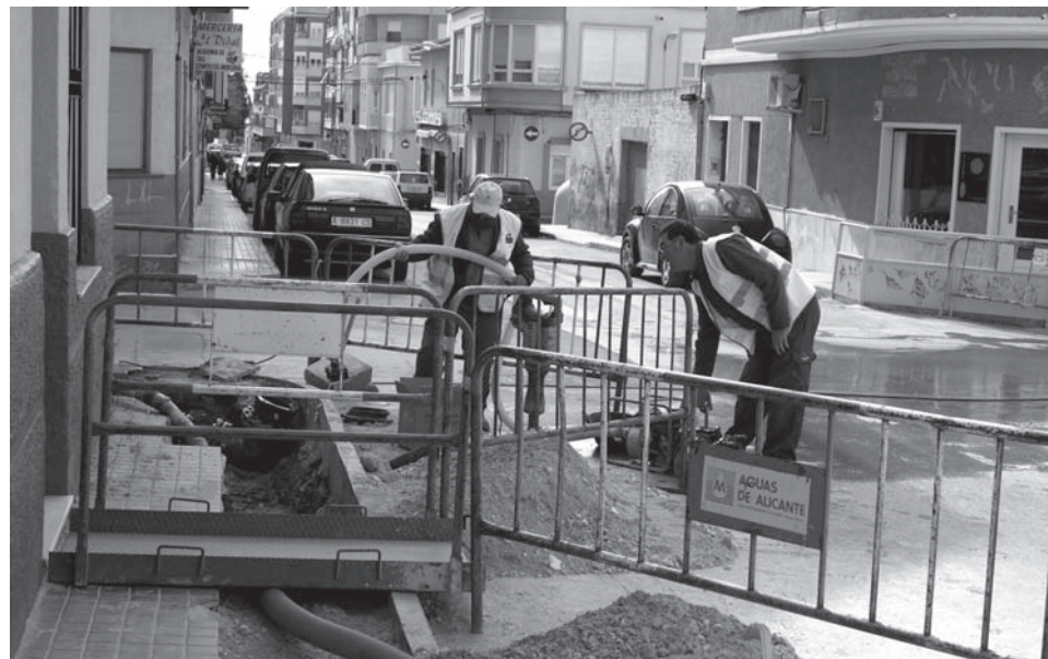
Obras realizadas por Aguas Municipalizadas de Alicante en la calle País Valenciano
