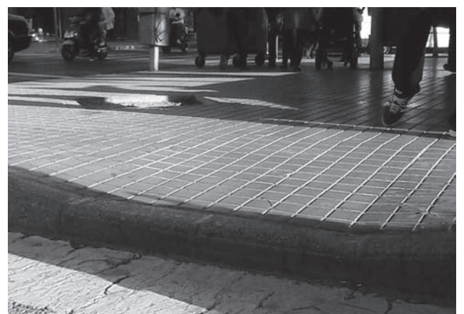
Rampa de accesibilidad en la avenida de Madrid
