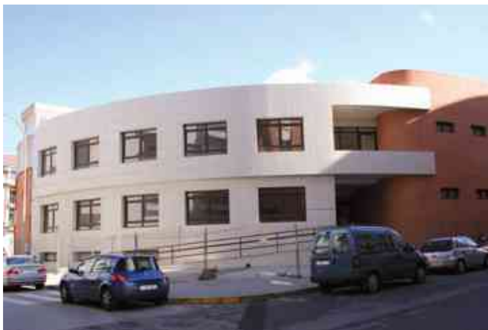
El edificio de la escuela de Música Tradicional pendiente de una cesión a la colla El Terròs
