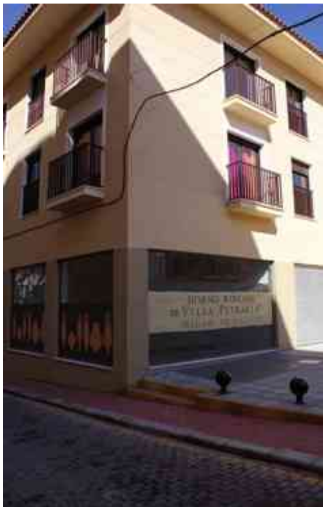
Los bajos del edificio La Font son del Ayuntamiento gracias a una permuta
