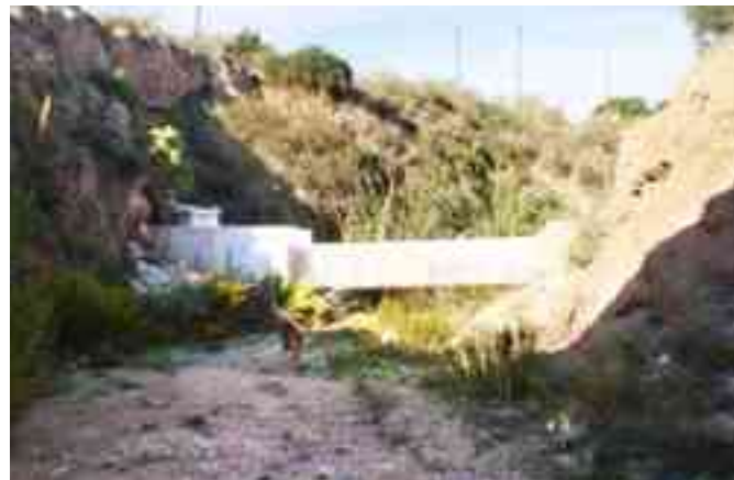
Un canal de agua interrumpe el paso.
