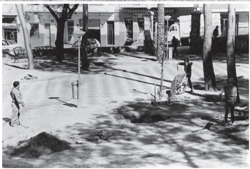
Any 1985. Obres de remodelació en el Jardí de les Escoles Nacionals.
