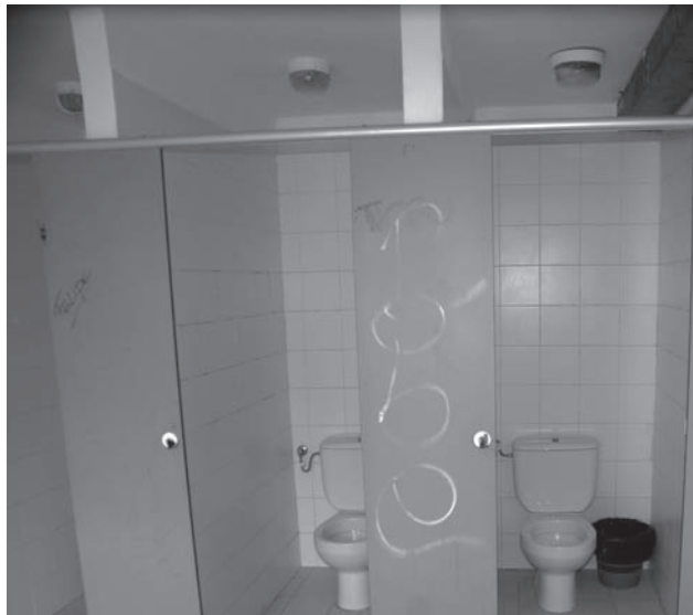
Estado en el que han quedado después de los trabajos
