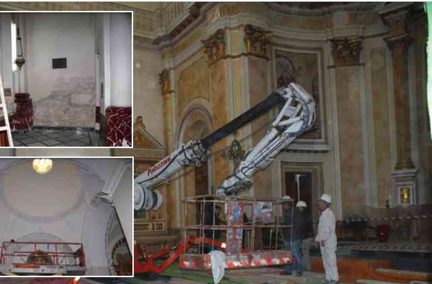
nto a la entrada. Detalle inferior: Restauración de una de las cúpulas laterales. Foto grande: Operarios junto al altar mayor con la maquinaria especial
