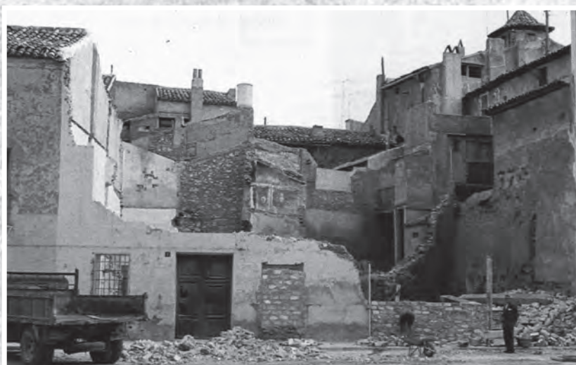
Any 1964. Demolició de les cases del Derrocat per a construir l'edifici Maracaibo.
