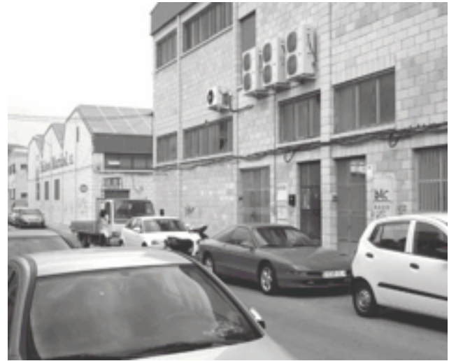
Imagen de una de las empresas ubicada en la calle Maestro Bartolomé
