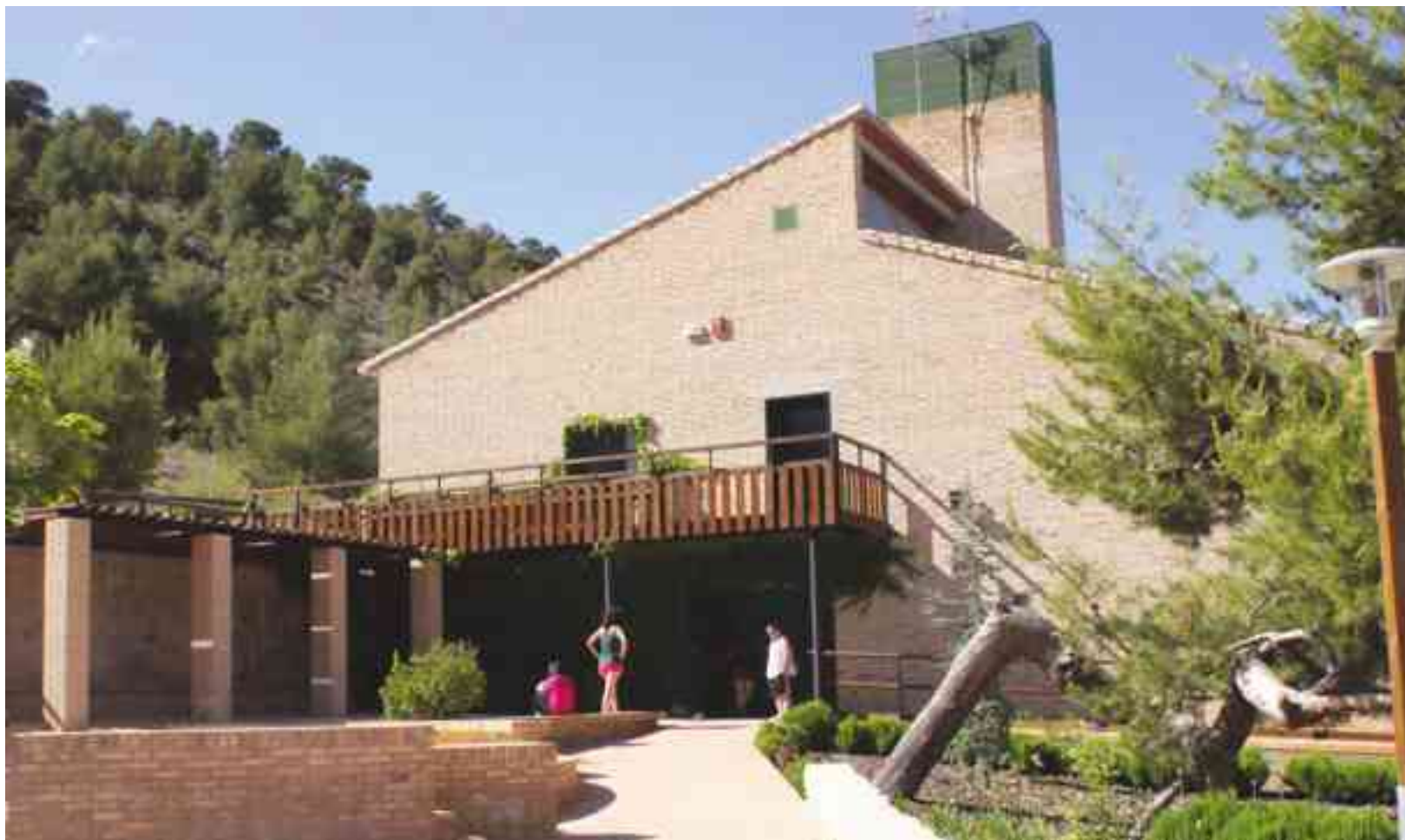
Fachada principal del albergue de L'Avaiol
