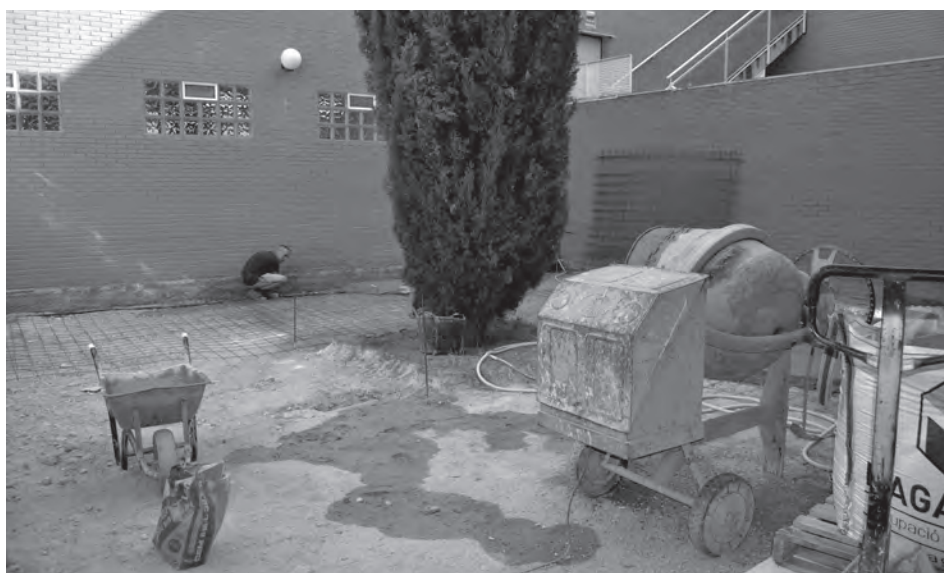
Obras en la biblioteca Enrique Amat
