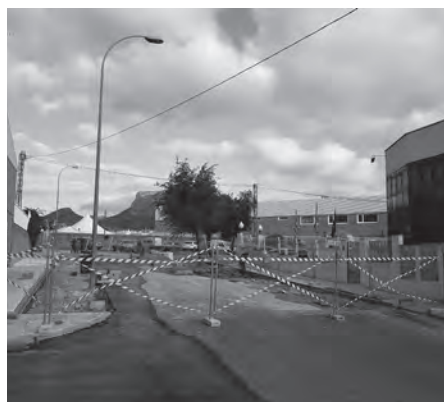
Imagen reciente de las obras
