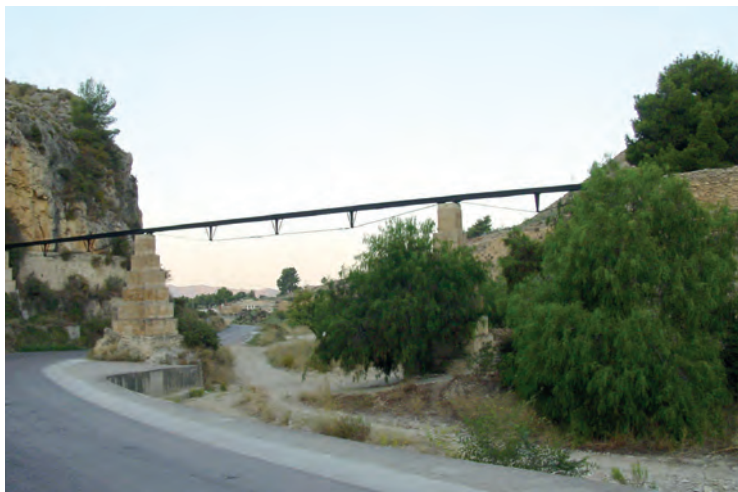
Imagen actual del canal de ferro
