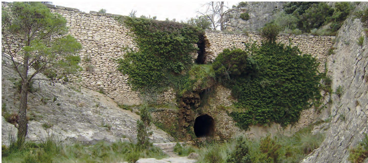
Vista general del pantanet visto desde aguas abajo.
