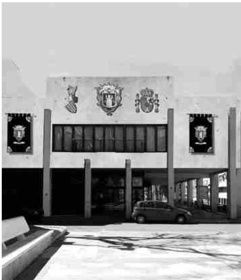
Montaje virtual de cómo quedará la fachada del Ayuntamiento con las redes de protección
