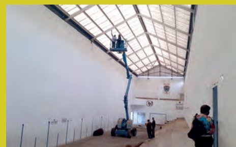
EN MARCHA LAS OBRAS DE MEJORA EN EL TRINQUETE MUNICIPAL
