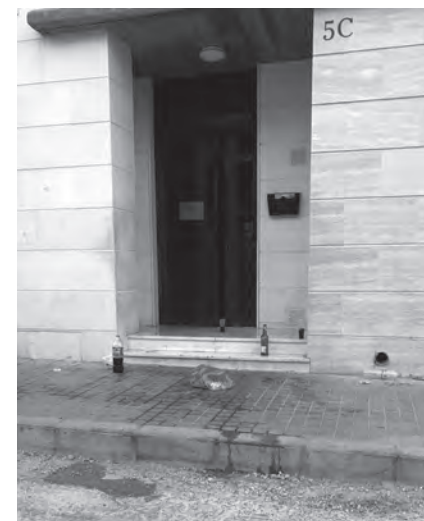
Estado de un portal de La Canal
