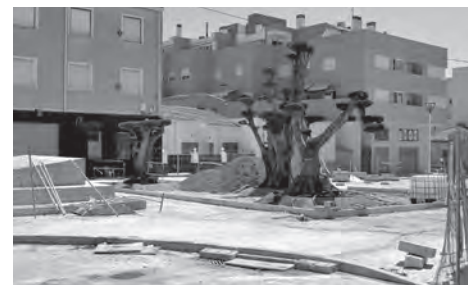
Obras en la Plaza América
