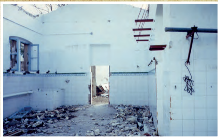
Any 1985. Interior de l'escorxador municipal, situat en l'Avd. del Guirney poc abans del seu derrocament.
