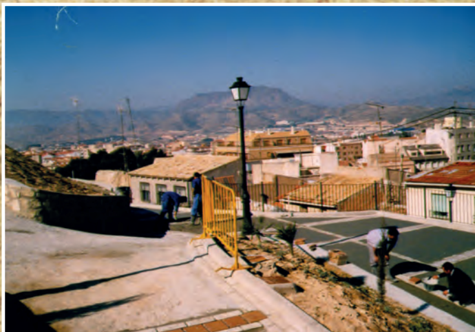
Any 1998. Obres de condicionament de la pujada a l'Altico.
