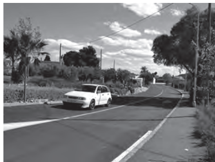
El carreteril tras la actuación
