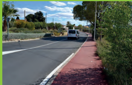
FINALIZADAS LAS OBRAS DEL CARRETERIL BASSA PERICO
