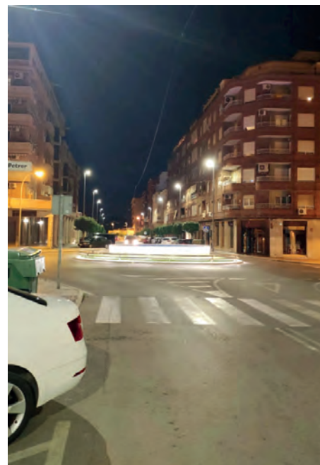
Renovación de la iluminación de la Avenida de Madrid
