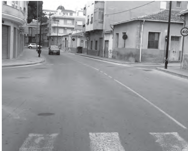
Avenida de Salinetas, una de las vías que se va a asfaltar
