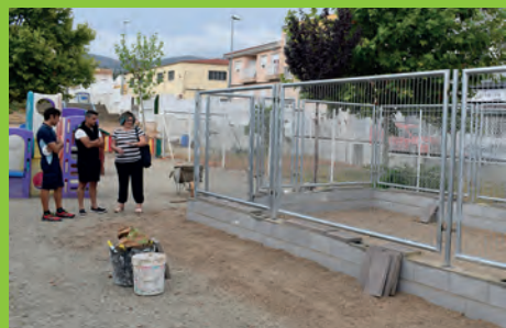
OBRAS DE MEJORA EN LOS COLEGIOS DE PETRER
