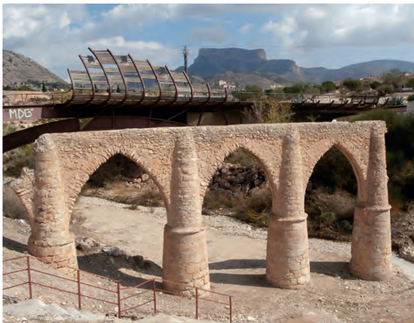
Acueducto de San Rafael
