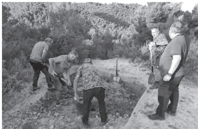
Construcción de un bebedero para animales
