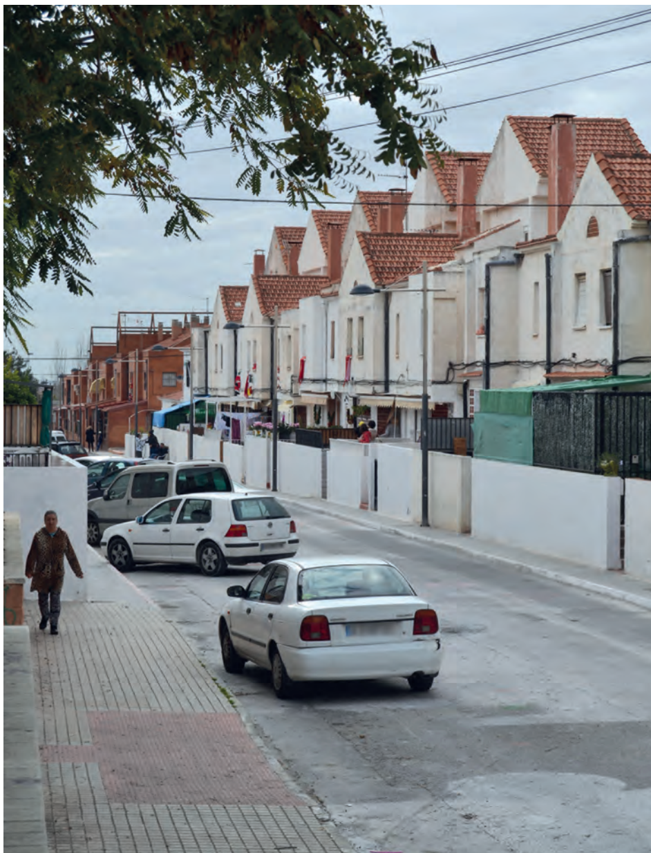
Dos viviendas de la calle Quevedo serán rehabilitadas
