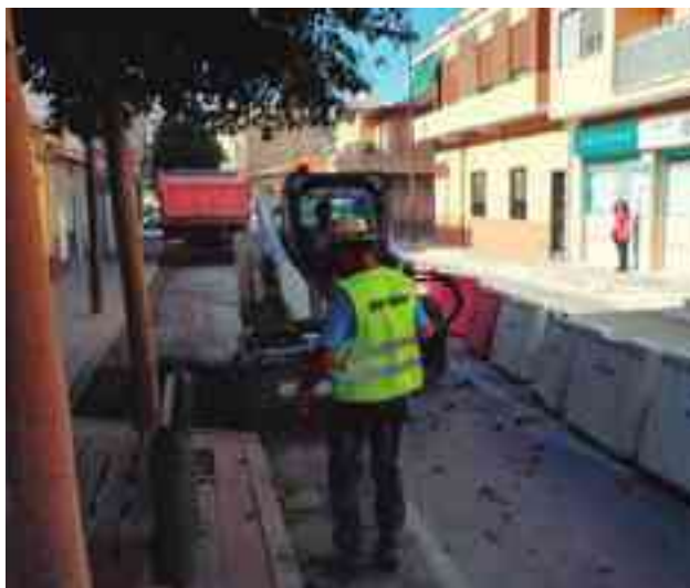
Obras en la avda. de Salinetas
