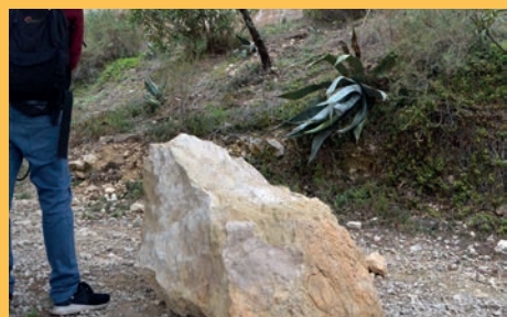
UNA GRAN ROCA CAE DE LA LADERA NORTE DEL CASTILLO
