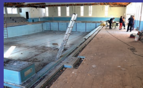
EN MARCHA LAS OBRAS DE LA PISCINA CUBIERTA
