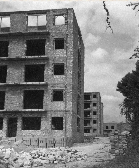
Los bloques, en el lateral de la calle Cid Campeador, en pleno proceso de construcción. Foto: Vicente Villaplana.
