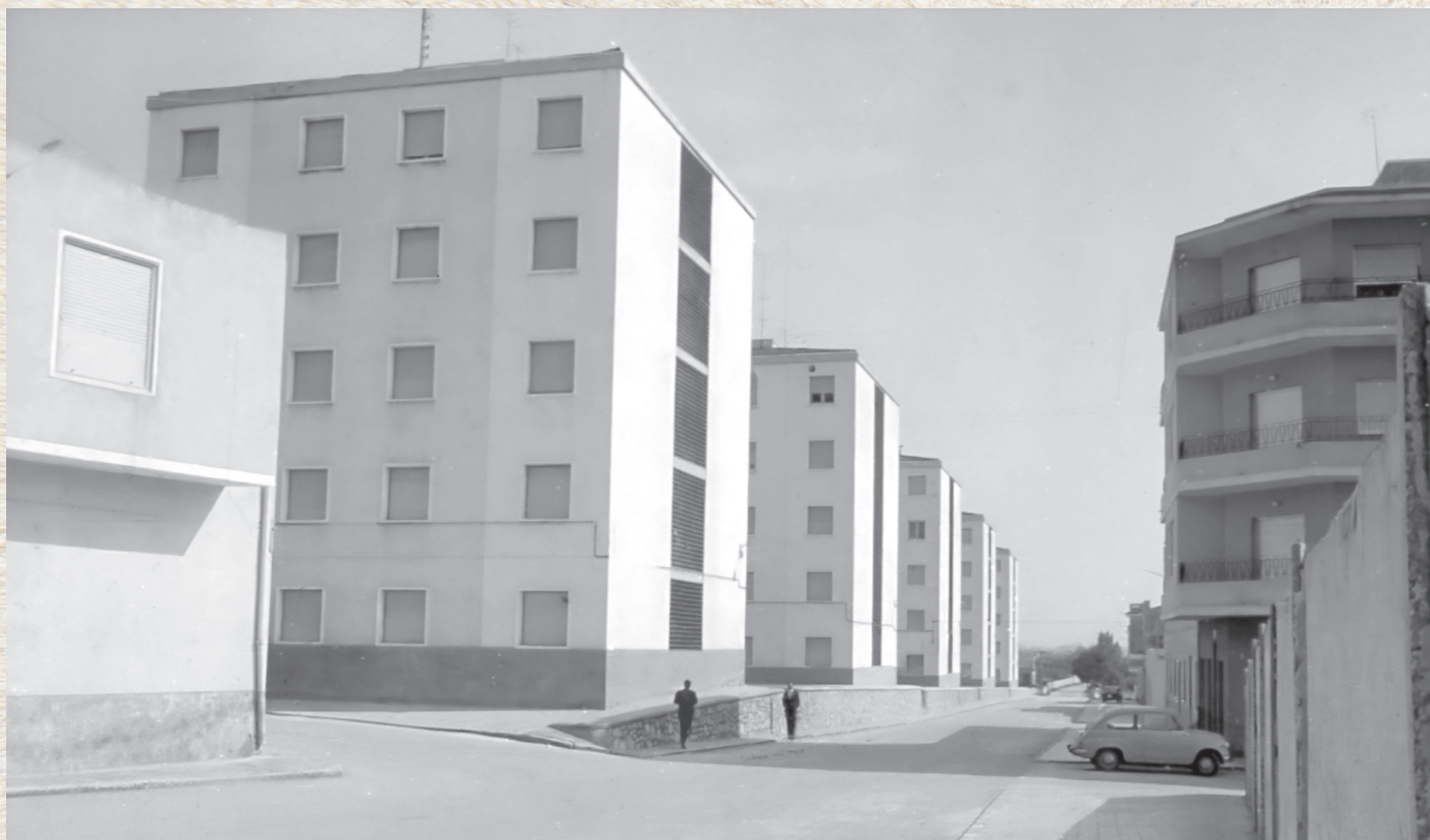
ANTES: los bloques recién construidos. Año 1961. Foto: José Esteve.
